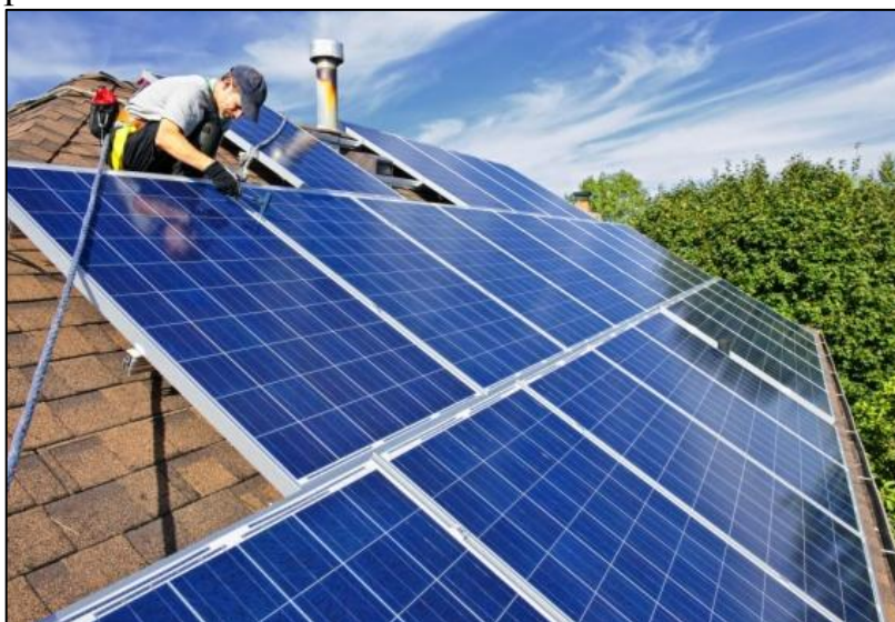
Рисунок 1 – Размещение солнечных батарей на крыше здания
